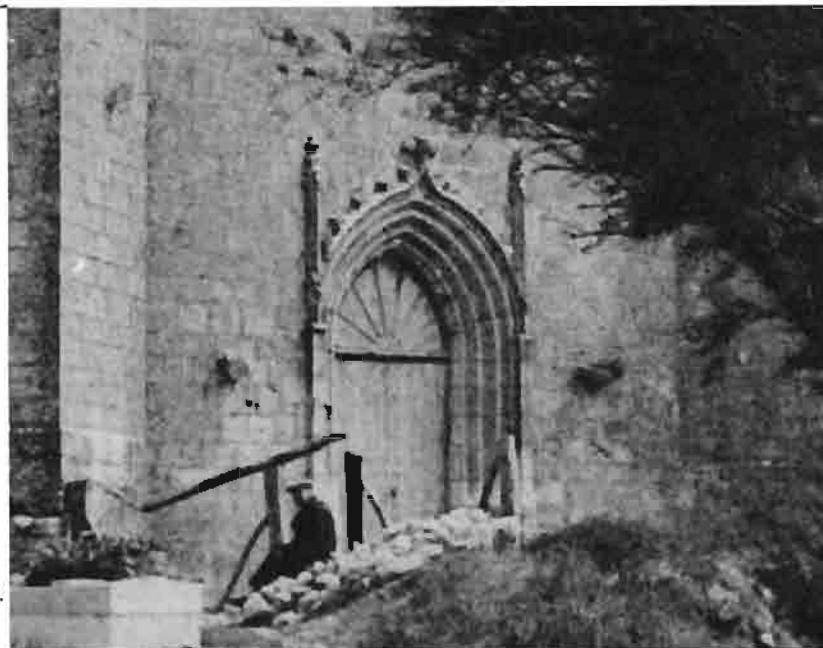
Début des travaux en 1928. À côté du personnage, l'engin de levage des déblais et les déblais déjà extraits.
