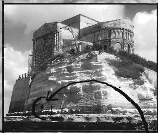
Vers 1960 - Réparation d'urgence d'une cavité creusée dans le premier mur de soutènement.
