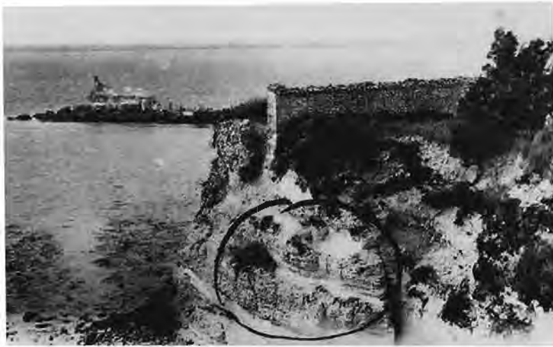
Sur cette photo datant d'avant 1918 (au fond le «Rocher du Sphinx» ou «Chatelet»), fractures verticales dans les terrains proches de l'église.
