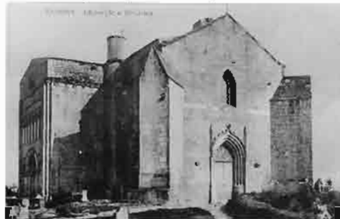
La façade ouest à la fin du XIXème siècle. Le ballet a été démoli. La trace de la toiture du premier ballet est encore visible sous la fenêtre.
