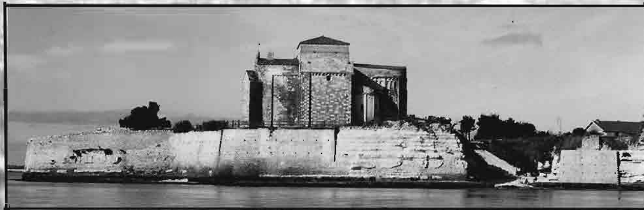
1950 - Les murs de soutènement vers la Gironde.
