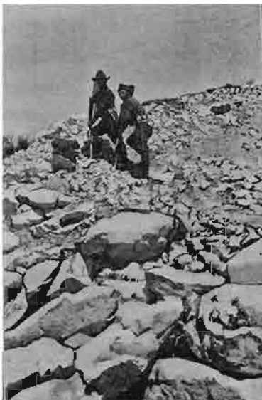
Soldats américains au travail sur les éboulis après les tirs de mine.
