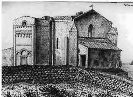
Le second ballet, vu par Auguin en 1840 On remarquera, sur le mur de façade et sur le contrefort Sud, la trace de la toiture du premier ballet.
