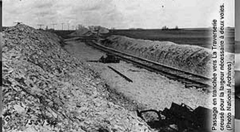
Passage en tranchée vers La Traverserie creusé pour la largeur nécessaire à deux voies. (Photo National Archives)
