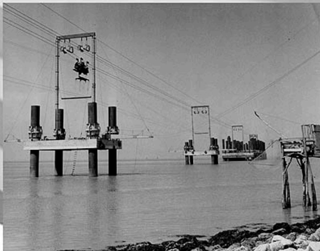
Les trois éléments du système de pontons De Long : de droite à gauche, l'appontement et les deux pontons-supports du téléphérique. Photo de l'auteur.
